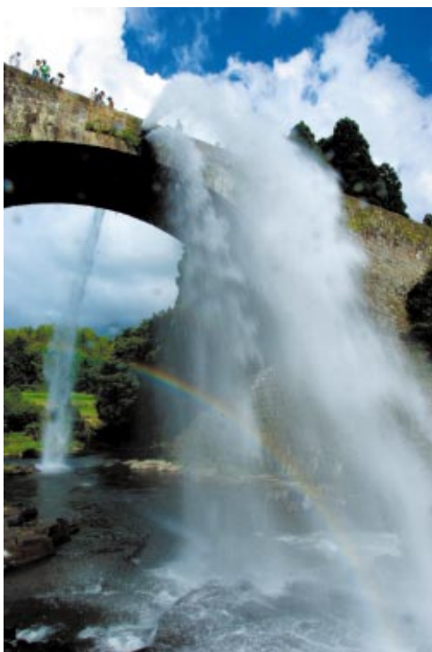
熊本県山都町(旧：矢部町)の通潤橋からの放水 水路橋としては日本一の規模を誇り、現在も水路として活用されています。 週末の正午には橋の中央から放水が行われ、壮大な水のアーチを描きます。 (時期により行われないことがありますのでご注意ください)
