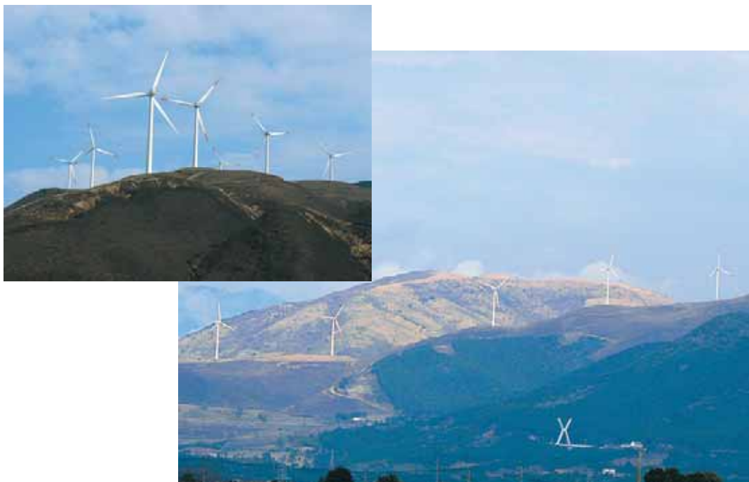
今では日本全国にある風力発電ですが、同仁化学研究所から東に見える俵山の斜面にも十基のプロペラが回っています。 「阿蘇にしはらウインドファーム」という施設で、阿蘇の外輪山の風の通り道を利用して発電しています。
